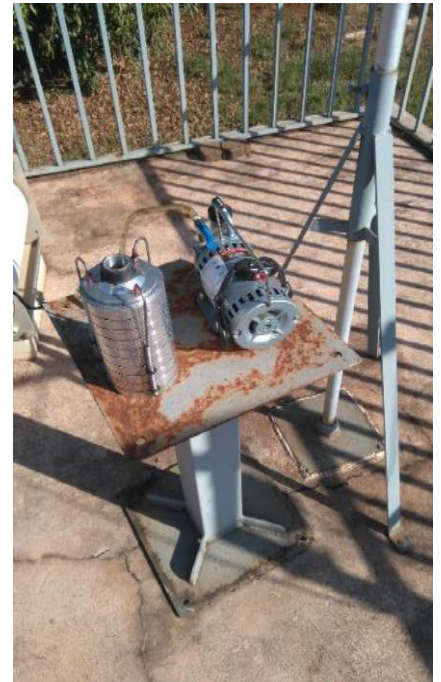
Abbildung 1 Anlage zum Filtern der Luft
